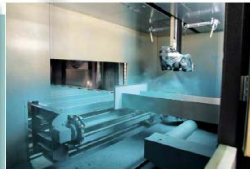
Lakkeringskabinettet settes i system med sandblåsing og varmebehandling og bidrar til en mer effektiv overflatebehandling av stål.
